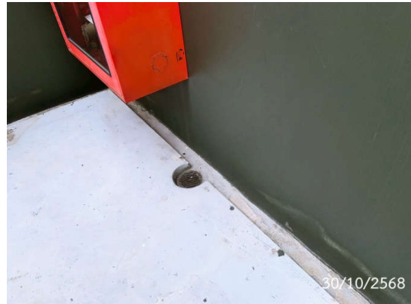
รูปที่ 2-72 ตะแกรงครอบตามรูท่อระบายน้ำทิ้ง
