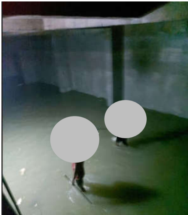
รูปที่ 2-21 การทำความสะอาดถังเก็บน้ำสำรอง
