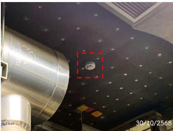
รูปที่ 2-43 อุปกรณ์ตรวจจับควันภายในห้องเครื่องไฟฟ้า (Smoke Detector)
