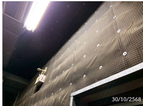
รูปที่ 2-46 ผนังดูดซับเสียง
