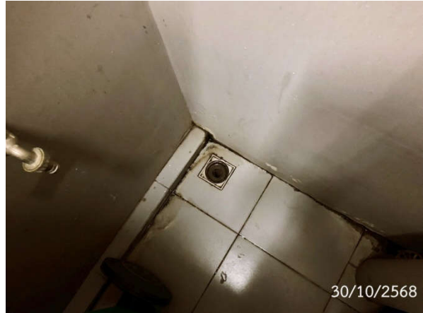
รูปที่ 2-40 ท่อรวบรวมน้ำเสียจากห้องพัสดุฝอย
