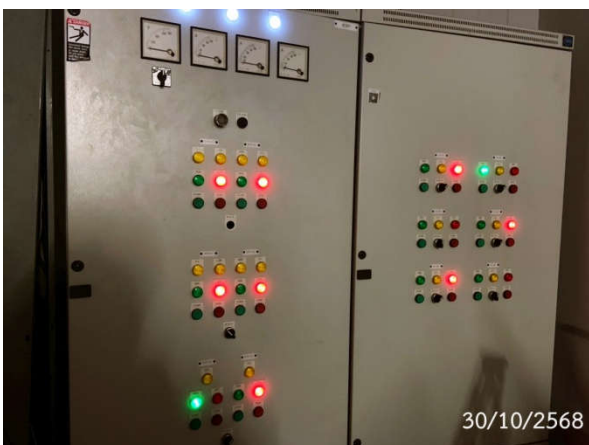
รูปที่ 2-14 ตู้ควบคุมระบบบำบัดน้ำเสีย
